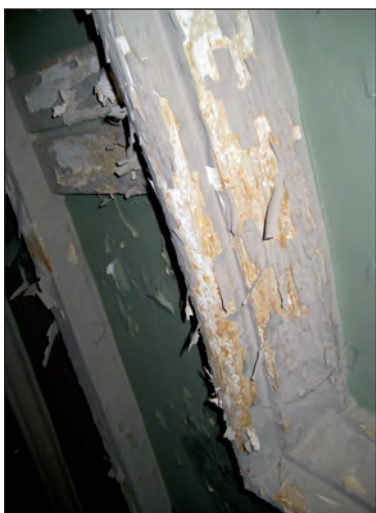
Fig. 1. Estado de conservación de las sucesivas capas de pintura aplicadas.
