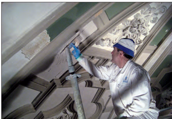
Fig. 5. Proceso de aplicación de yesos en plementos lisos.
